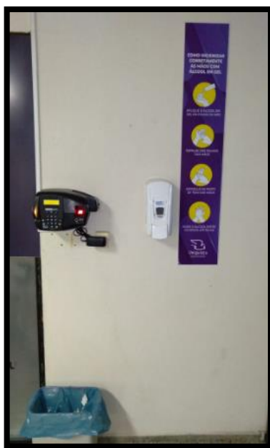
Figura 96. Ponto biométrico para registro dos colaboradores.
